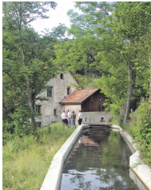
Wasserkraftwerk in Ramiswil
